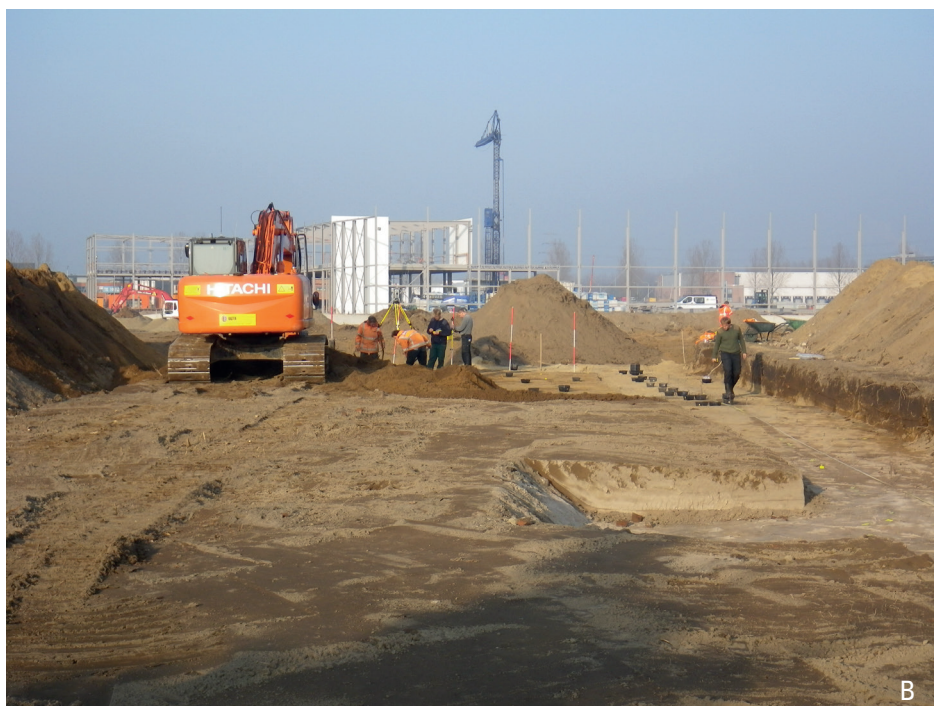
Fig. 2.10. Wijchen - Bijsterhuizen vindplaats 11. A werkzaamheden op het perceel Banken; B werkzaamheden in werkput 45, met op de achtergrond de bouw op perceel Banken; C werkput 21 op de voorgrond. Rechts achteraan is te zien dat na het dichten van werkputten 1 en 2 de werkzaamheden hier reeds gestart zijn.
